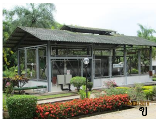
ภาพที่ 9 ภาพแสดงการพัฒนาพุน้ำร้อนฝาง (ก) หลุมเจาะบ่อน้ำร้อน (ข) โรงไฟฟ้าความร้อนใต้พิภพ 300 กิโลวัตต์ แบบสองวงจร
