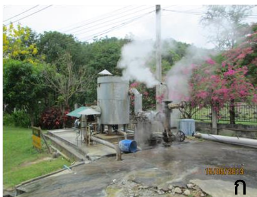
ภาพที่ 9 ภาพแสดงการพัฒนาพุน้ำร้อนฝาง (ก) หลุมเจาะบ่อน้ำร้อน (ข) โรงไฟฟ้าความร้อนใต้พิภพ 300 กิโลวัตต์ แบบสองวงจร
