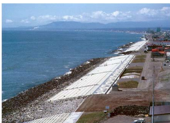
กำแพงป้องกันคลื่นริมชายหาดแบบลาดเอียงน้อยโดยการปูพื้นชายหาดด้วยก้อนหินหรือก้อนคอนกรีตเป็นขั้นบันไดไปตามความลาดเอียงของชายหาดลงสู่ทะเลในญี่ปุ่น (สนับสนุนภาพจาก ดร. มานะ ภัทรพานิช กรรมการผู้จัดการ บริษัท ซีเอสเปคตรัม จำกัด)
