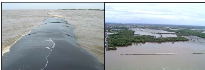
การใช้ไส้กรอกทรายเป็นแนวป้องกันและแก้ไขปัญหาคัดเซาะบริเวณชายฝั่งทะเล อำเภอคลองด่าน จังหวัดสมุทรปราการ (สนับสนุนภาพจากกรมทรัพยากรทางทะเลและชายฝั่ง)
