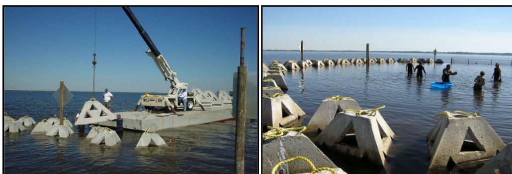
การวางแนวปะการังเทียมคอนกรีตหล่อรูปสามเหลี่ยมบริเวณอ่าวเพนซาโคลา (Pensacola Bay) มลรัฐฟลอริดา สหรัฐอเมริกา ภายใต้โครงการ GreenShores ซึ่งได้รับรางวัล Coastal America 2003 Partnership Award (สนับสนุนภาพจาก Project GreenShores Team and Coastal Restoration, Inc., Florida, USA)
