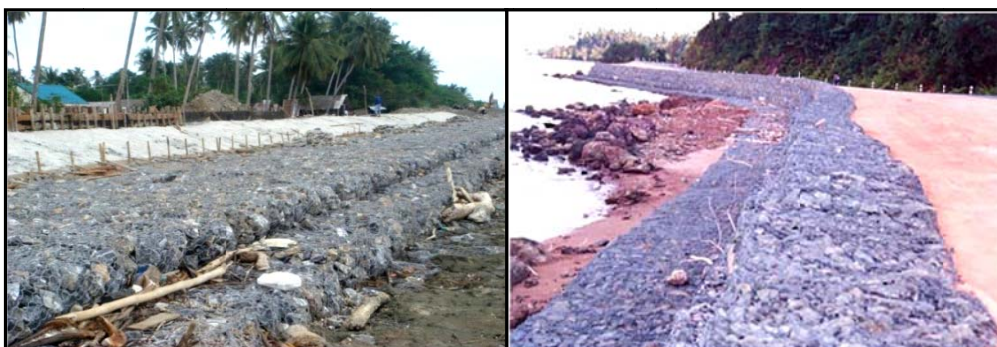
ภาพแนวกล่องกระชุนป้องกันการกัดเซาะชายฝั่งทะเล (ซ้าย) บริเวณหาดแหลมสน ตำบลแหลมสน อำเภอกะเปอร์ จังหวัดระนอง และ (ขวา) บริเวณบ้านสลักเพชร อำเภอกะช้าง จังหวัดตราด
