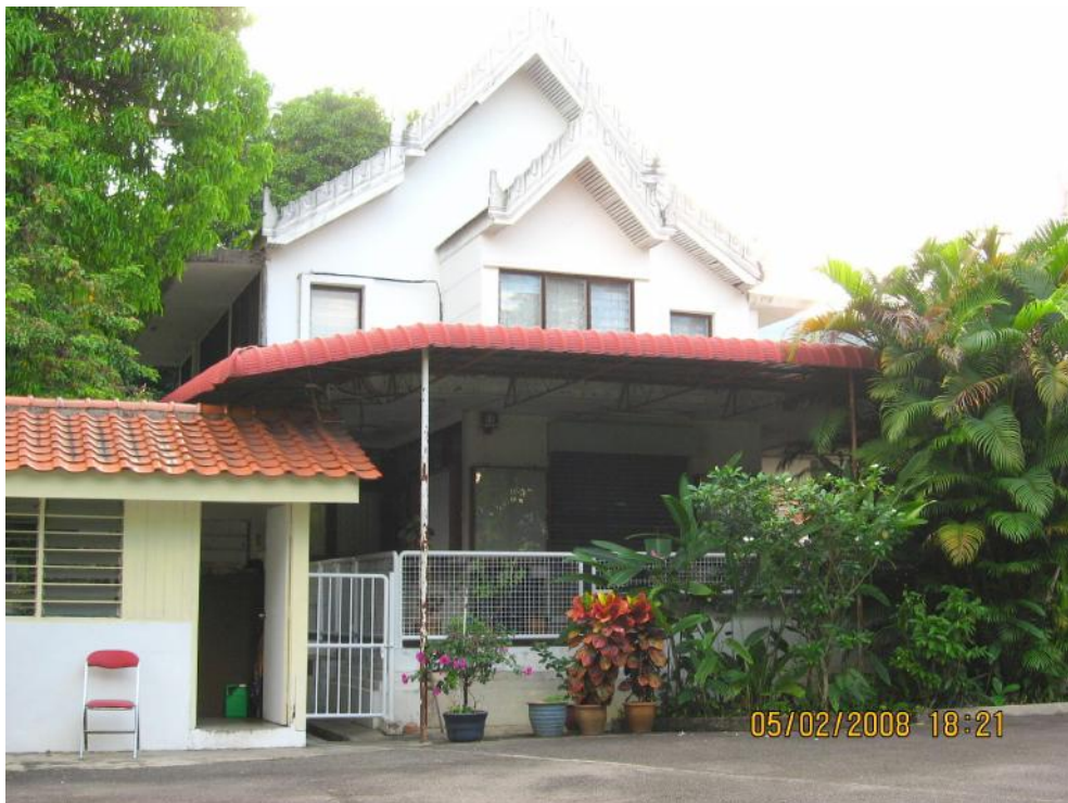
อาคารที่ทำการสถานกงสุลใหญ่ซึ่งอยู่ติดกันมีอายุกว่า 40 ปี
