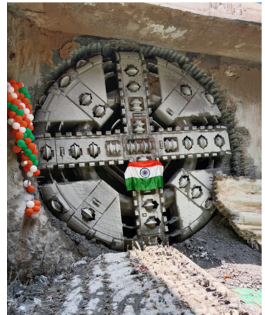
เครื่องเจาะอุโมงค์ของบริษัท Robbins เจาะทะลุถึงสถานี Tughlakabad Railway Colony ได้สำเร็จ ถือเป็นการเสร็จสิ้นสัญญา DC07 ของโครงการรถไฟฟ้าใต้ดินเดลีอย่างสมบูรณ์ (ที่มา: www.robbinstbm.com/es/delhi-metro-2025/ )
