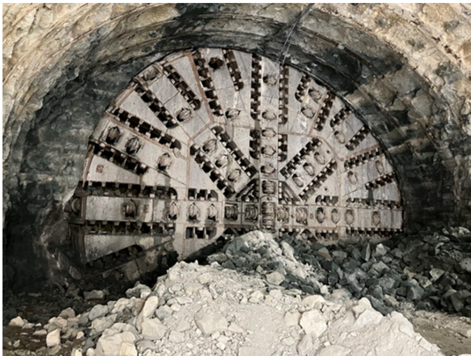
เครื่องเจาะอุโมงค์แบบ Slurry ของบริษัท Robbins ขนาดเส้นผ่านศูนย์กลาง 13.67 เมตร (44.87 ฟุต) เจาะทะลุสำเร็จในฤดูใบไม้ผลิปี 2025 ถือเป็นการเสร็จสิ้นการขุดเจาะผ่านชั้นหินแกรนิตที่มีความท้าทายสูงและแรงดันน้ำใต้ดินสูง (ที่มา: www.robbinstbm.com/hiroshima-breakthrough/ )
