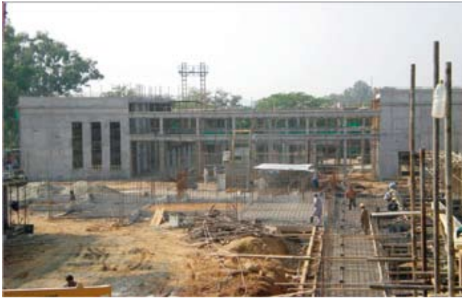
โครงการก่อสร้างอาคารที่ทำการสถานเอกอัครราชทูต ณ กรุงอิสลาแมบัด
