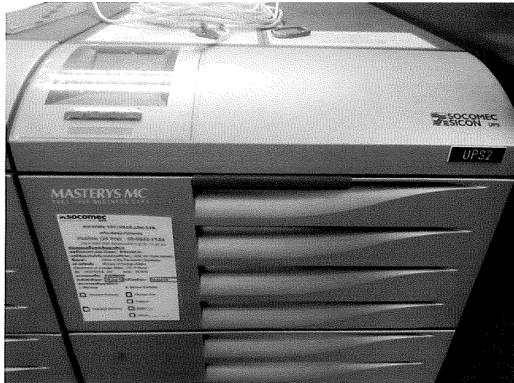
รูปที่ ๔ UPS ขนาด ๖๐kVA เดิมที่จะต้องขนย้ายออกจากพื้นที่
