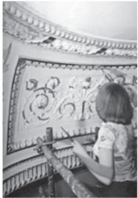
งานบูรณะปฏิสังขรณ์ภายในพระราชวังหลวง
