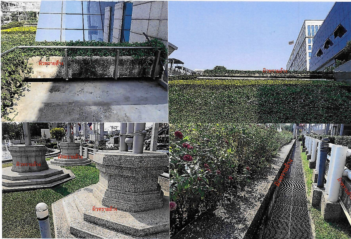
- งานขัดล้างผิวทรายล้าง ด้านหน้าอาคารทั้งหมด
