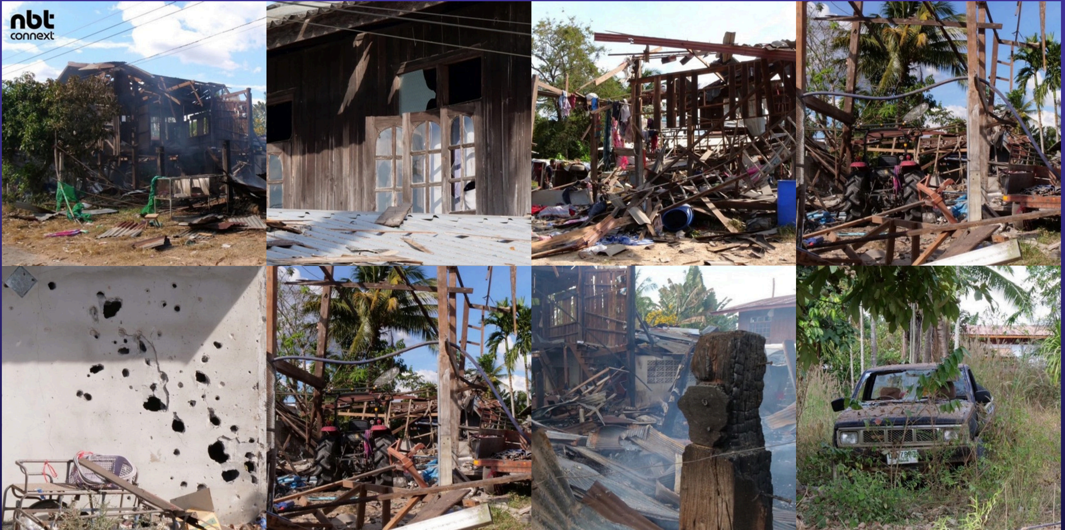
ภาพความเสียหายบ้านเรือนประชาชน จากการโจมตีของกัมพูชา Images of damage to civilian homes from the Cambodian attacks.
