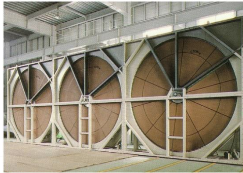
▲ โรเตอร์ VOC เข้มข้น ซีโอไลต์ที่ไม่ชอบน้ำได้รับการปรับปรุงบนอันนี้แคมป์บ่อนินทรีย์
