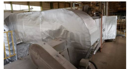
▲ นอกจากนี้ยังมีแผ่นสำหรับปรับปรุงประสิทธิภาพเชิงความร้อนของอุปกรณ์เครื่องจักรกล และแผ่นสำหรับป้องกันการกลั่นตัวเป็นหยดน้ำในอุปกรณ์ทำความเย็นและแช่แข็ง
