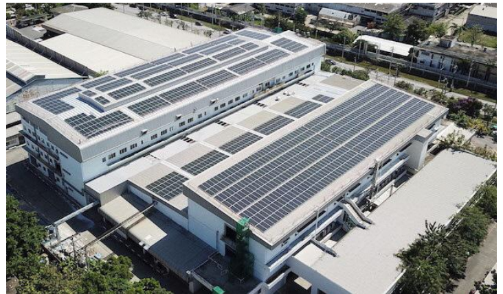
▲ ตัวอย่างการติดตั้งโรงไฟฟ้าพลังงานแสงอาทิตย์แบบติดตั้งบนหลังคา
