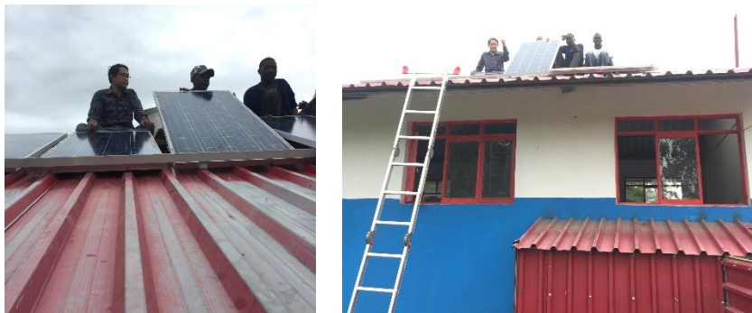
รูปภาพ การขึ้นไปซ่อมบำรุงแผงโซลาร์เซลล์บนหลังคาอาคารเรียน
